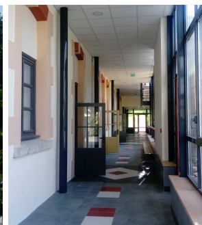
Face sud, ajout d'un espace tampon vitré, mur sud à gauche gardé tel quel.
