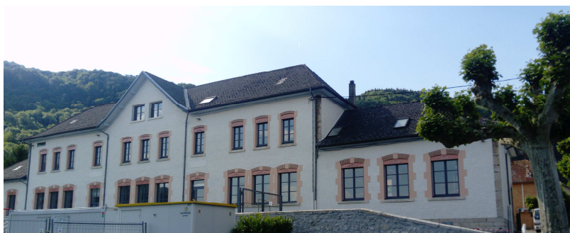
Face nord, intacte, seule les menuiseries sont changées.
